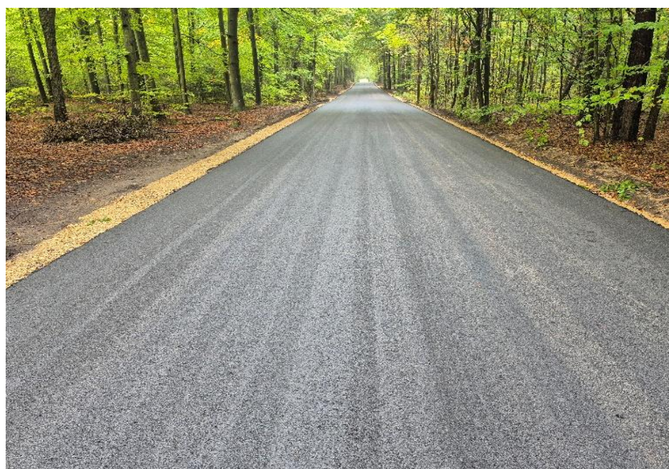
Zdj. DP 1078 S Cisie – DW 492, gm. Blachownia przed i po przebudowie
