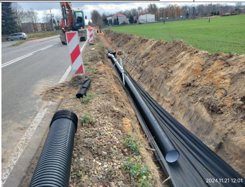
Zdj. DP 1024 S, odc. Adamów – Skrzydlów, chodnik w trakcie budowy.
