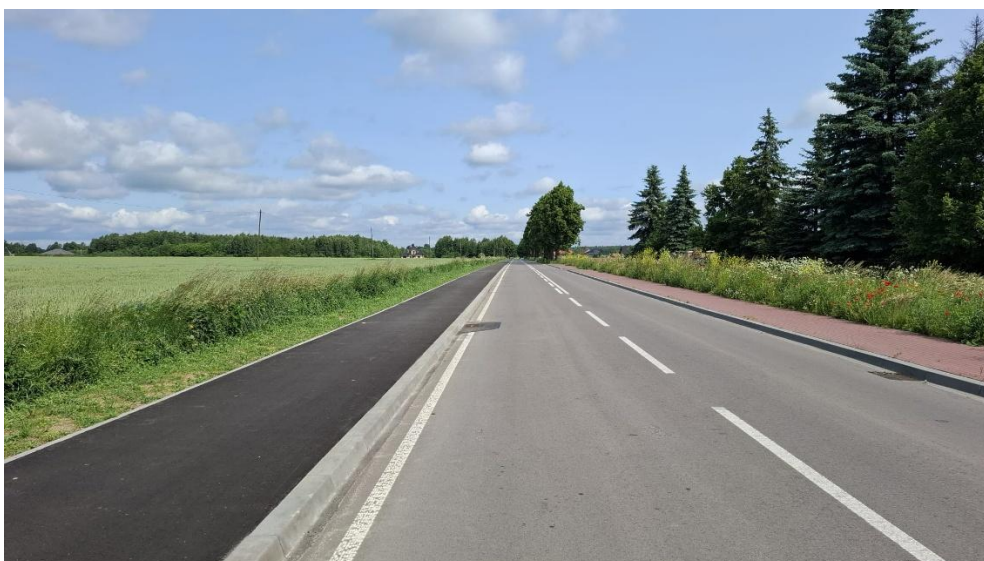
Zdj. DP 1024 S, odc. Adamów – Skrzydlów, chodnik w trakcie i po przebudowie.
