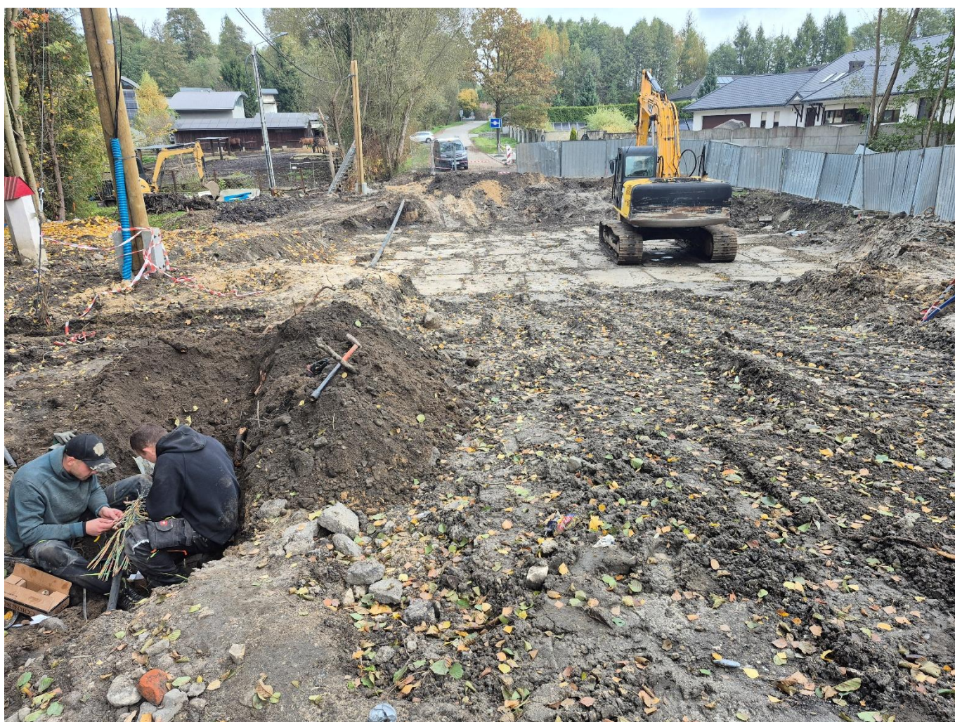
Zdj. DP 1076 S, Gorzelnia, gm. Blachownia w trakcie przebudowy
