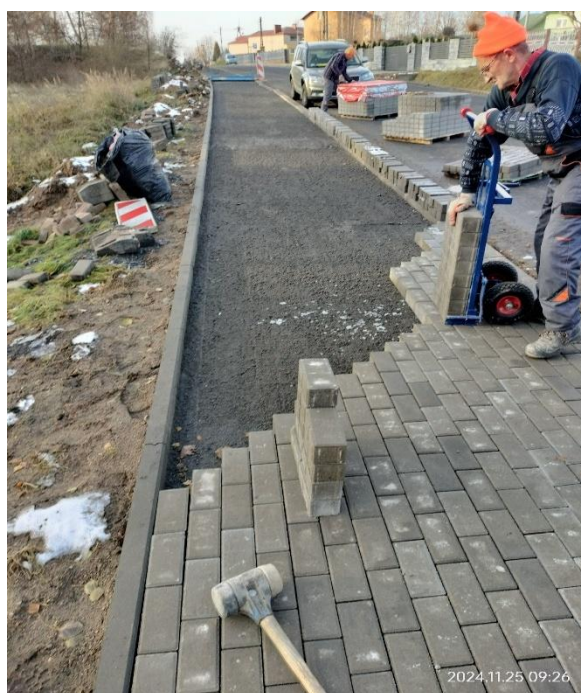
Zdj. DP 1057 S, odc. Wrzosowa - Huta Stara B, gm. Poczesna droga w trakcie przebudowy.
