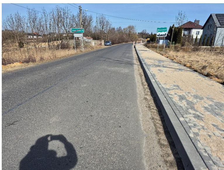
Zdj. DP 1057 S, odc. Wrzosowa - Huta Stara B, gm. Poczesna droga w trakcie przebudowy.
