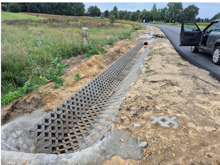
Zdj. DP 1005 S Rędziny ul. Szkolna i Jaskrów ul. Ołowianka w trakcie przebudowy.
