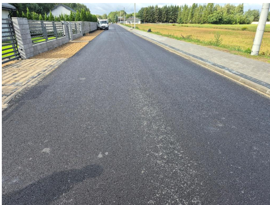
Zdj. DP 1051 S ul. Piaskowa w m. Aleksandria Pierwsza w trakcie przebudowy.
