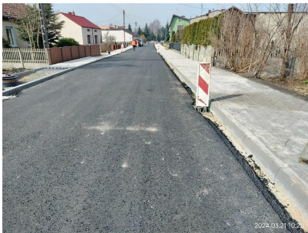
Zdj. DP 1072, Stary Broniszew, gm. Mykanów droga w trakcie przebudowy.
