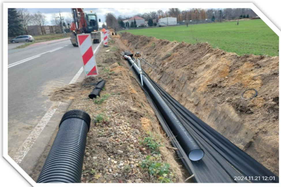
Zdj.43. DP 1024 S, odc. Adamów – Skrzydlów, chodnik w trakcie budowy
