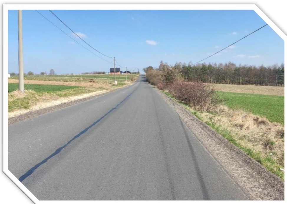
Zdj.51,52. DP 1028 S odc. Wancerzów - Kłobukowice, gmina Mstów przed przebudową i po przebudowie
