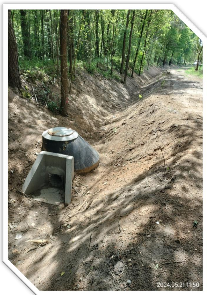
Zdj.47,48. DP 1024 S Budowa odwodnienia służącego poprawie jakości odprowadzanych wód opadowych i roztopowych w miejscowości Rzerzeczyce, gm. Kłomnice
