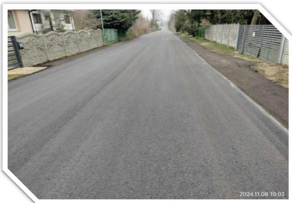
Zdj.67. DP 1087 S ul. Straży Pożarnej, gm. Dąbrowa Zielona po przebudowie
