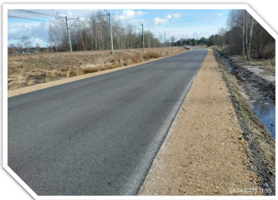
Zdj.71. DP 1042 S w m-ści Kusięta, gmina Olsztyn po przebudowie
