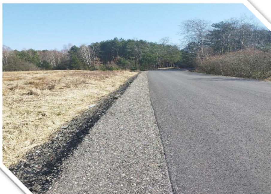
Zdj.55,56. DP 1092 S odc. Rudniki – gr. województwa, Gmina Koniecpol – ETAP I przed przebudową i po przebudowie
