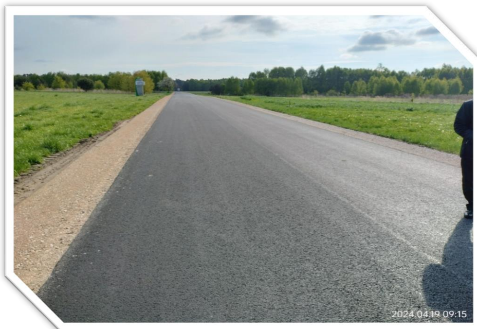
Zdj.74. DP 1081S odc. Cielętniki – granica województwa, gmina Dąbrowa Zielona po przebudowie
