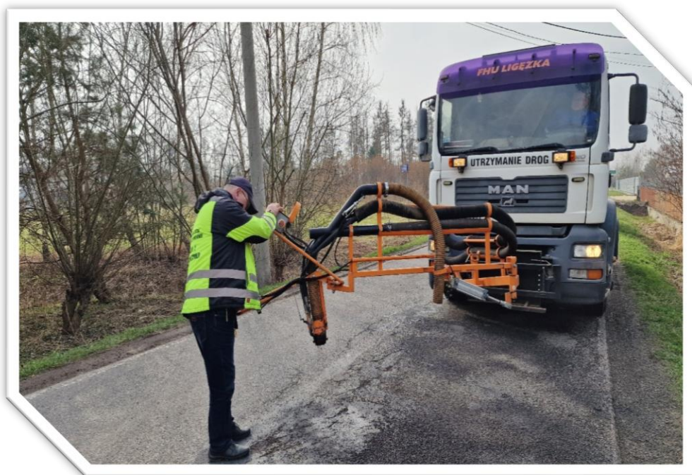
Zdj.79. zakupionego remontera drogowego podczas pracy
