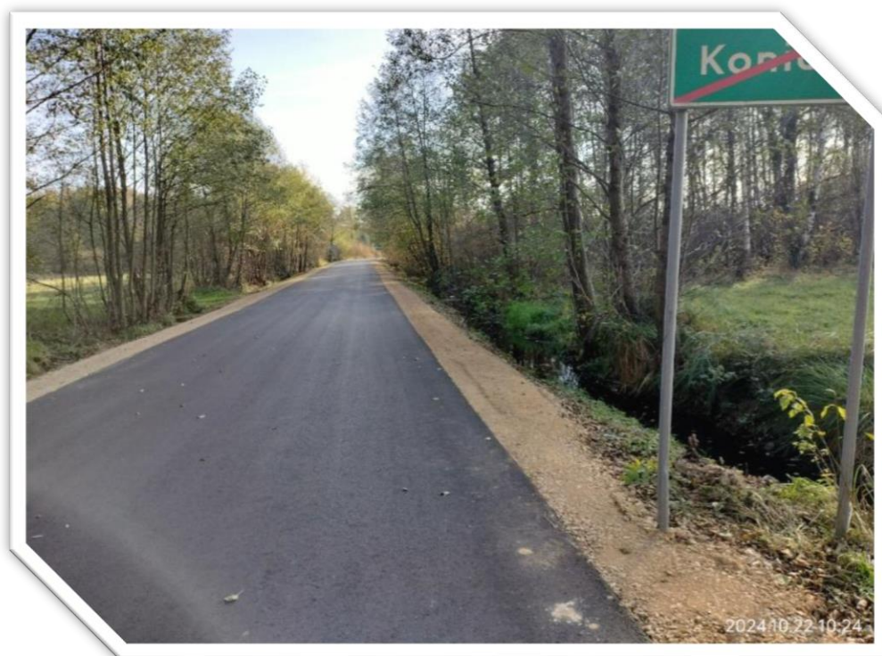
Zdj.58. DP 1103 S odc. Koniawy – Wąsosz, gmina Koniecpol po przebudowie
