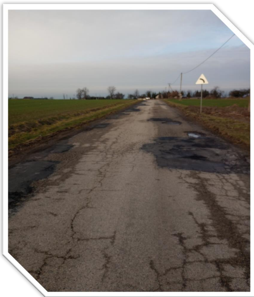
Zdj.59.DP 1115 S odc. Nakło – Zawadka, gmina Lelów przed przebudową
