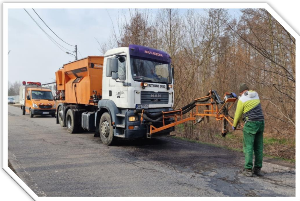
Zdj.78. zakupionego remontera drogowego podczas pracy
