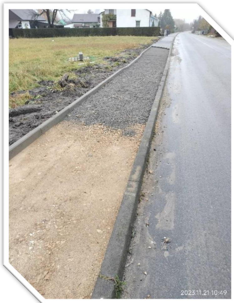
Zdj.68. DP 1087 S ul. Straży Pożarnej, gm. Dąbrowa Zielona w trakcie przebudowy
