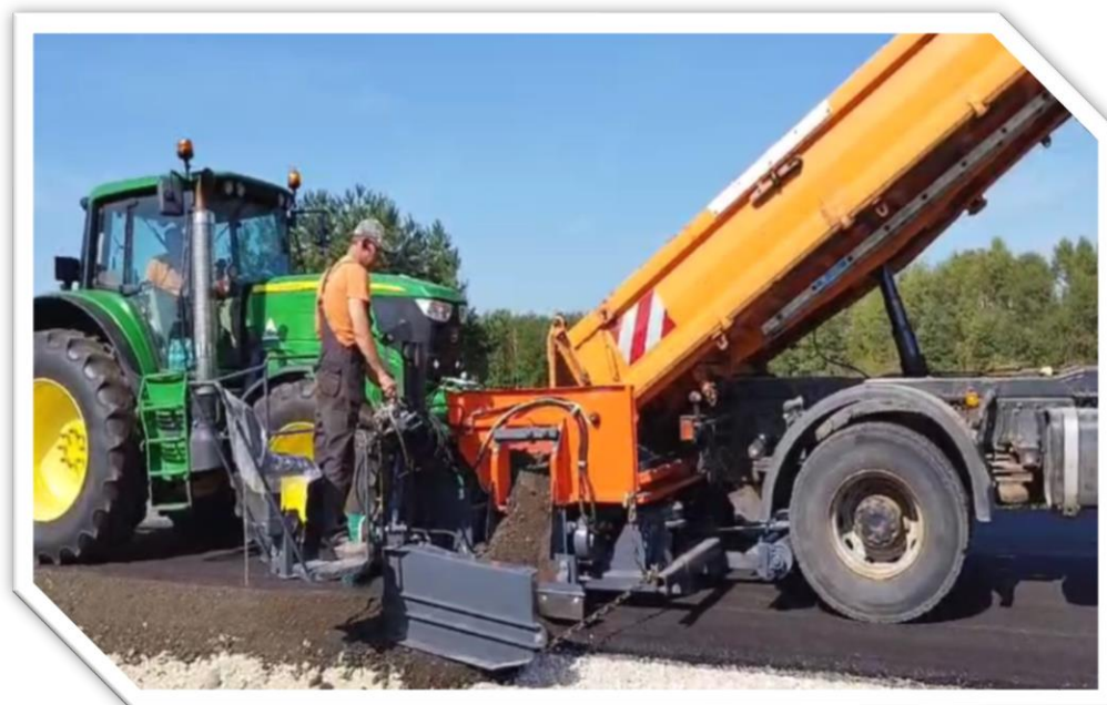
Zdj.89,90,91. Układarka poboczy
