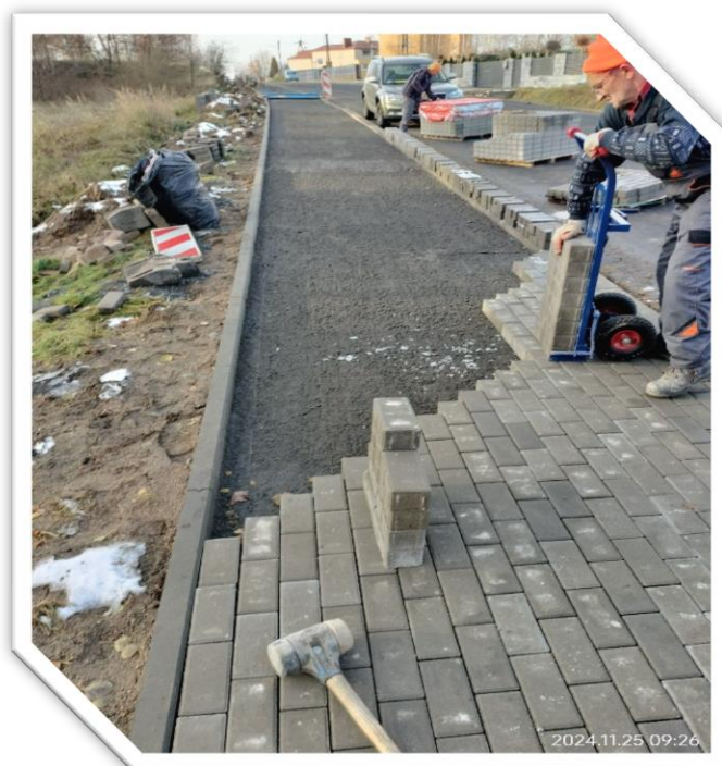
Zdj.39. DP 1057 S, odc. Wrzosowa - Huta Stara B, gm. Poczesna droga w trakcie przebudowy
