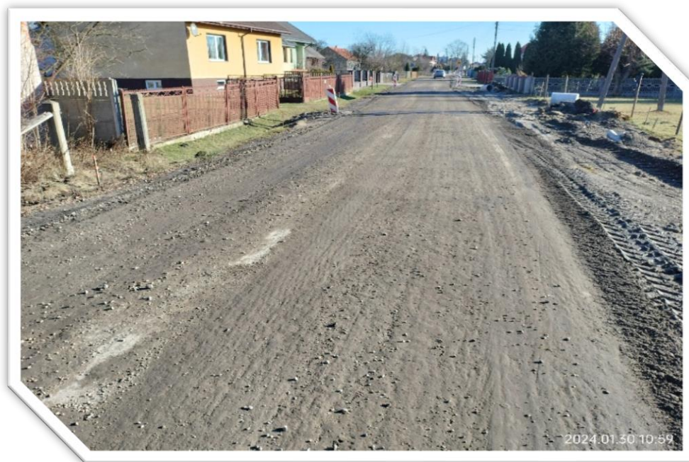
Zdj.37. DP 1072, Stary Broniszew, gm. Mykanów droga w trakcie przebudowy
