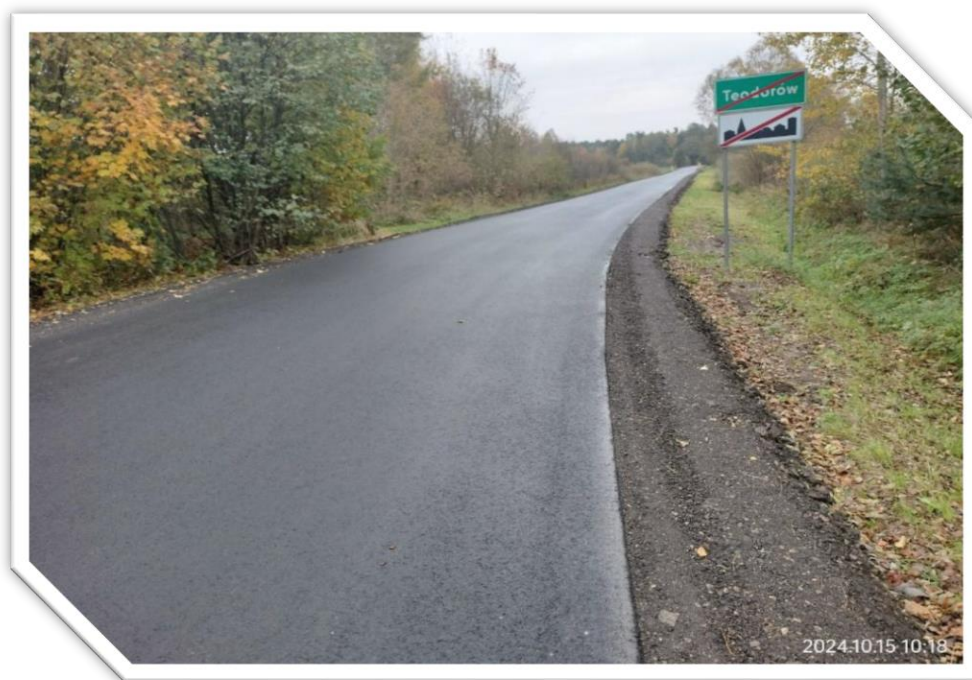
Zdj.62. DP 1101 S odc. Konstantynów - Teodorów, gmina Lelów po przebudowie
