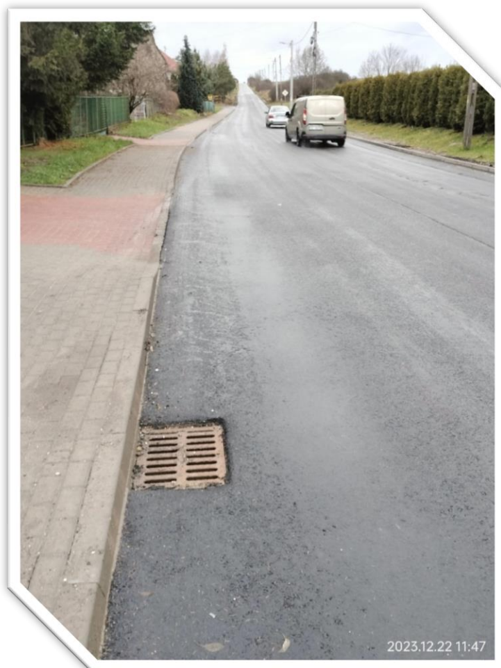
Zdj.72. DP 1038 S w Małusy Wielkie, gmina Mstów po przebudowie
