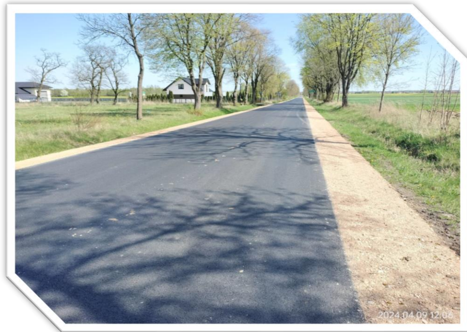
Zdj.73. DP 1030S odc. Kłomnice - Zawada, gmina Kłomnice po przebudowie
