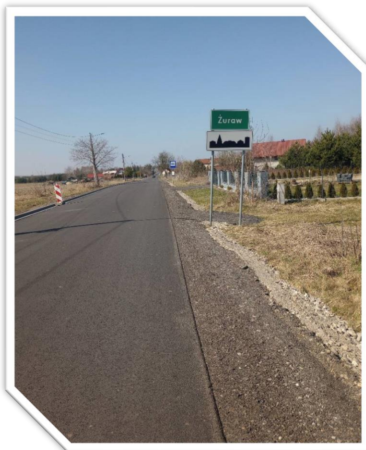
Zdj. 64.DP 1039 S odc. Żuraw – Lipnik, gmina Janów po przebudowie
