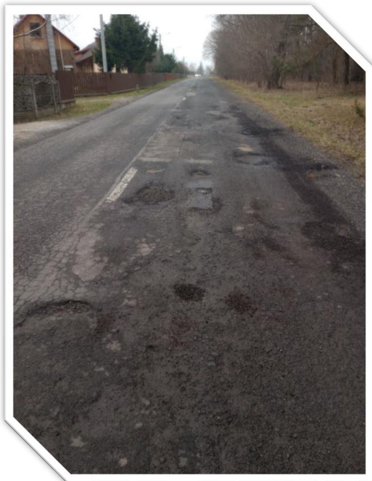
Zdj.65. DP 1096 S odc. Podlesie – Celiny, gmina Lelów przed przebudową i po przebudowie
