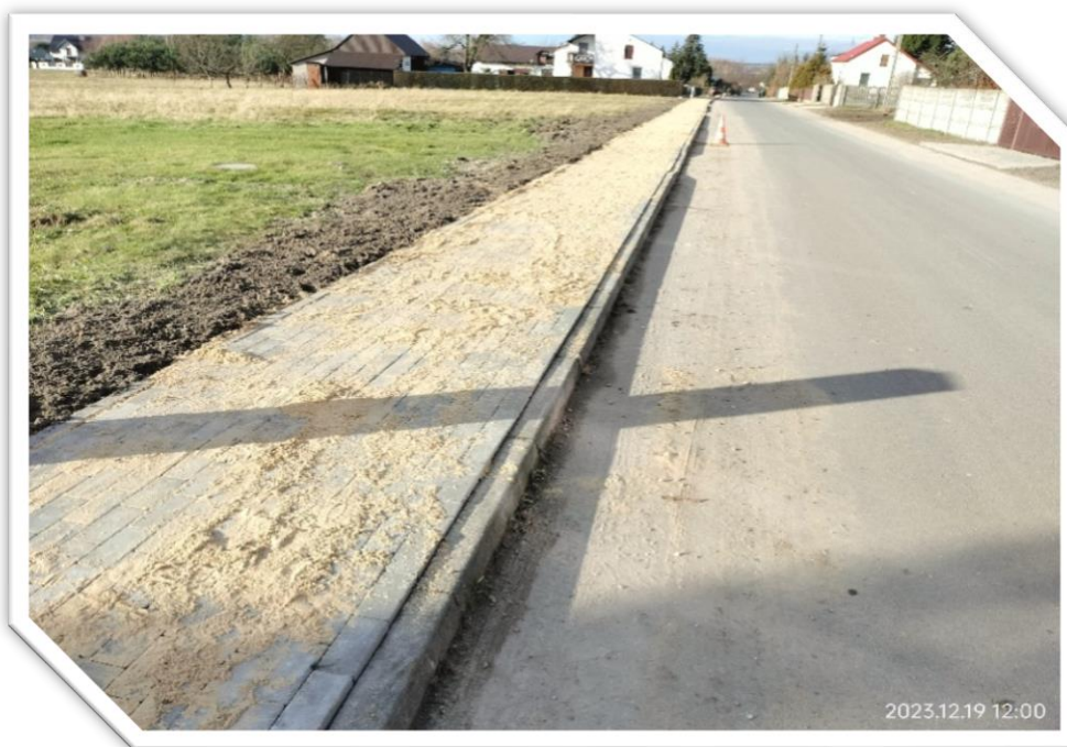
Zdj.66. DP 1087 S ul. Straży Pożarnej, gm. Dąbrowa Zielona po przebudowie
