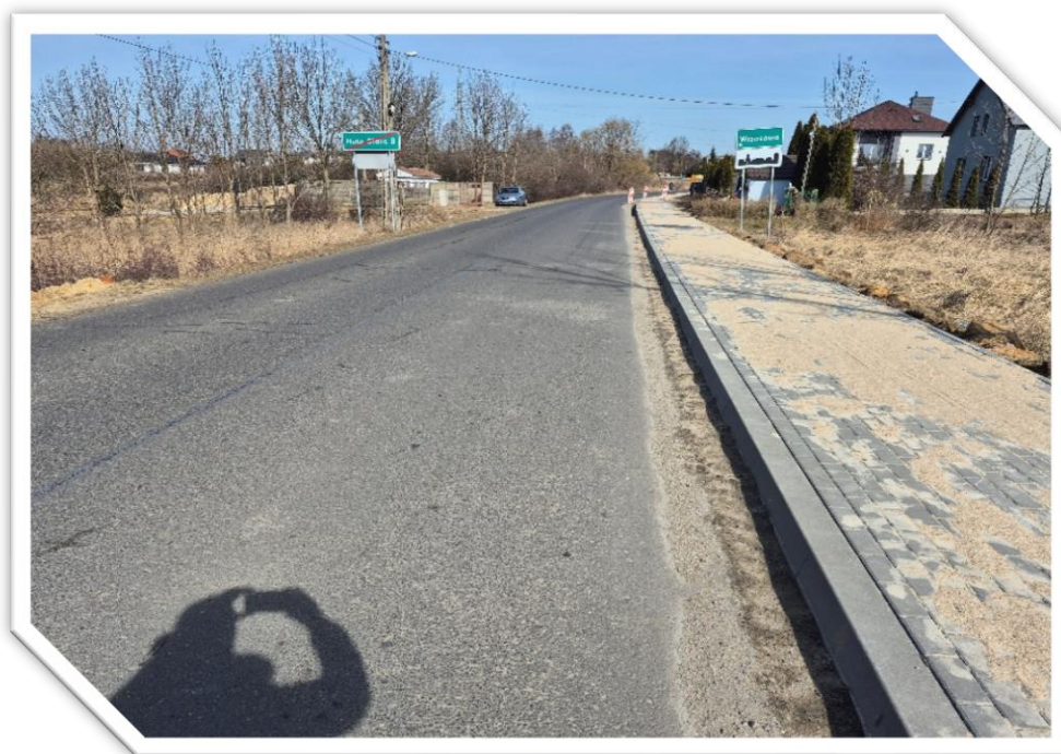
Zdj.40. DP 1057 S, odc. Wrzosowa - Huta Stara B, gm. Poczesna droga po przebudowie
