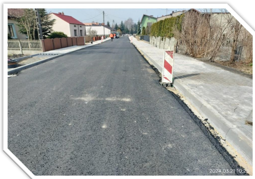
Zdj.38. DP 1072, Stary Broniszew, gm. Mykanów droga w trakcie przebudowy
