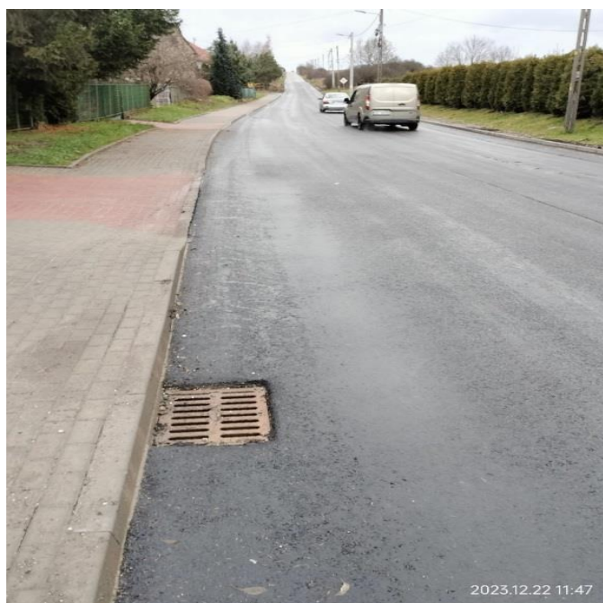
Zdj.41. DP 1038 S po przebudowie
