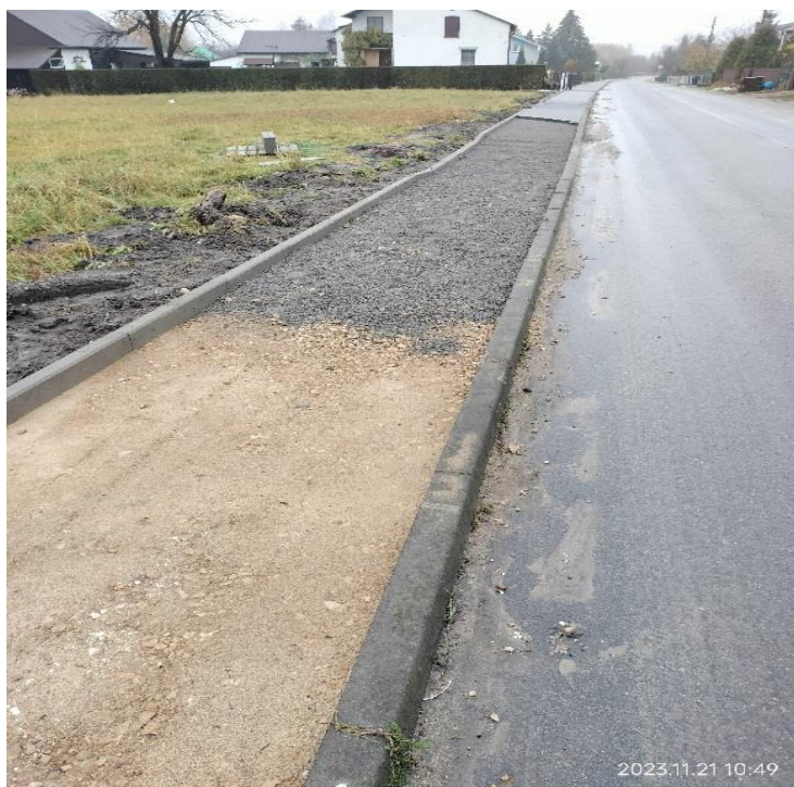
Zdj.47. DP 1087 S w trakcie przebudowy
