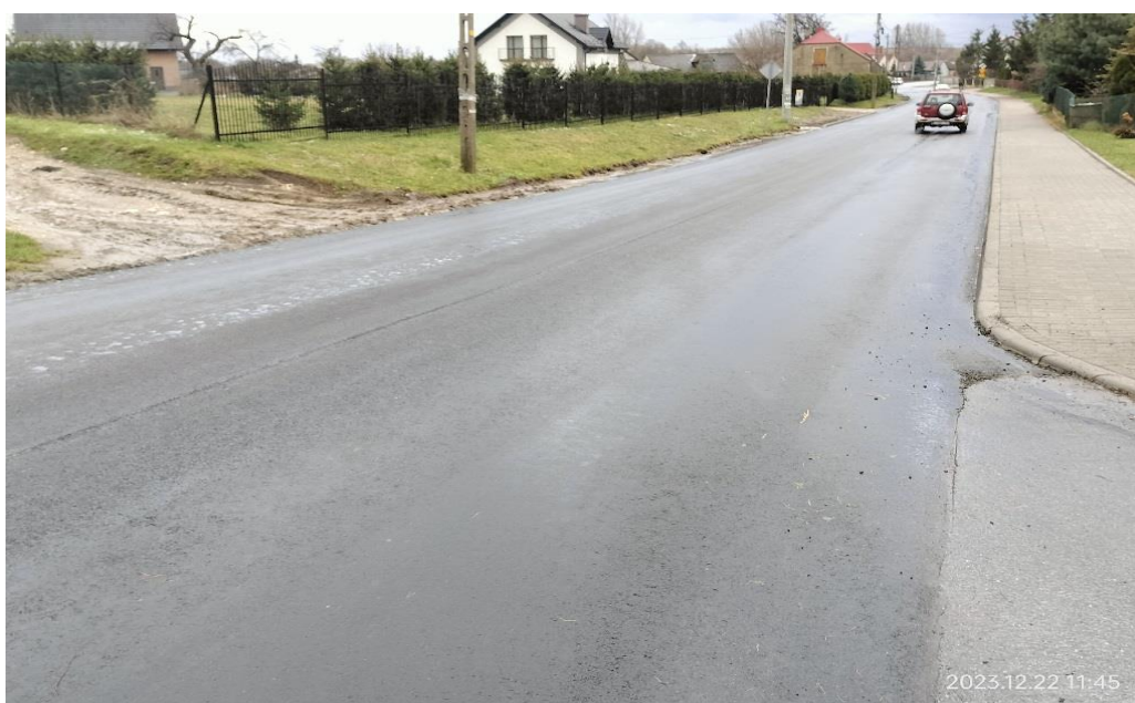
Zdj.42. DP 1038 S po przebudowie
