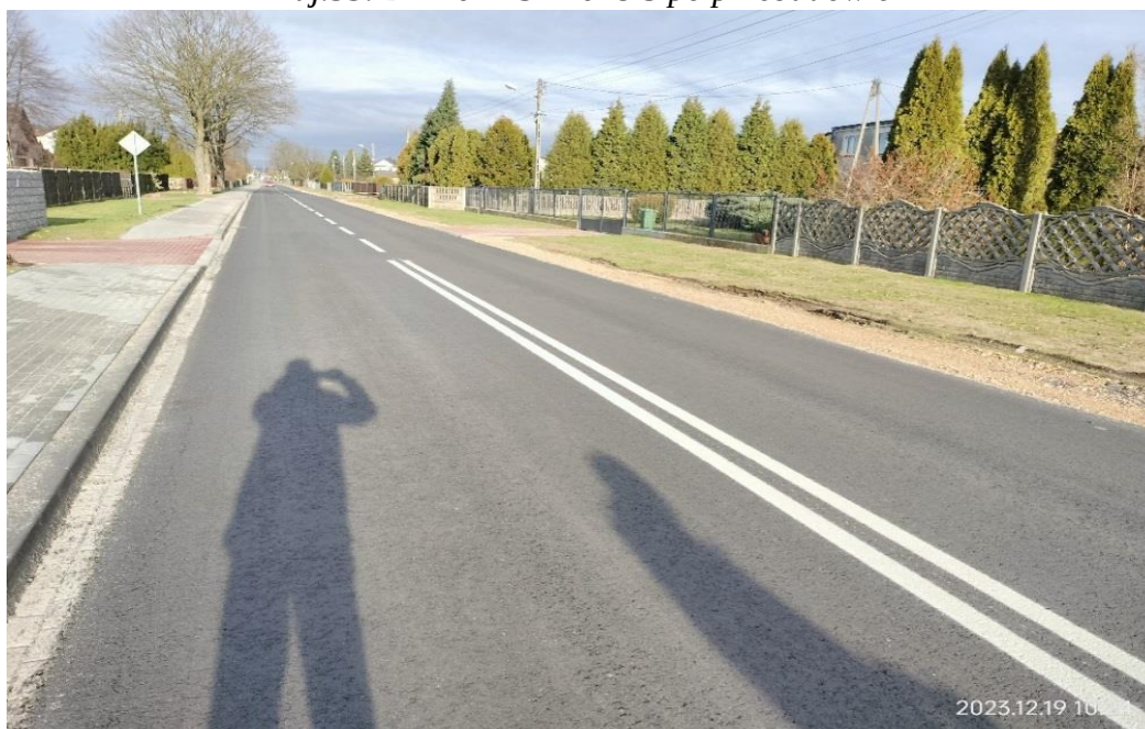
Zdj.34.DP 1024 S i 1028 S po przebudowie
