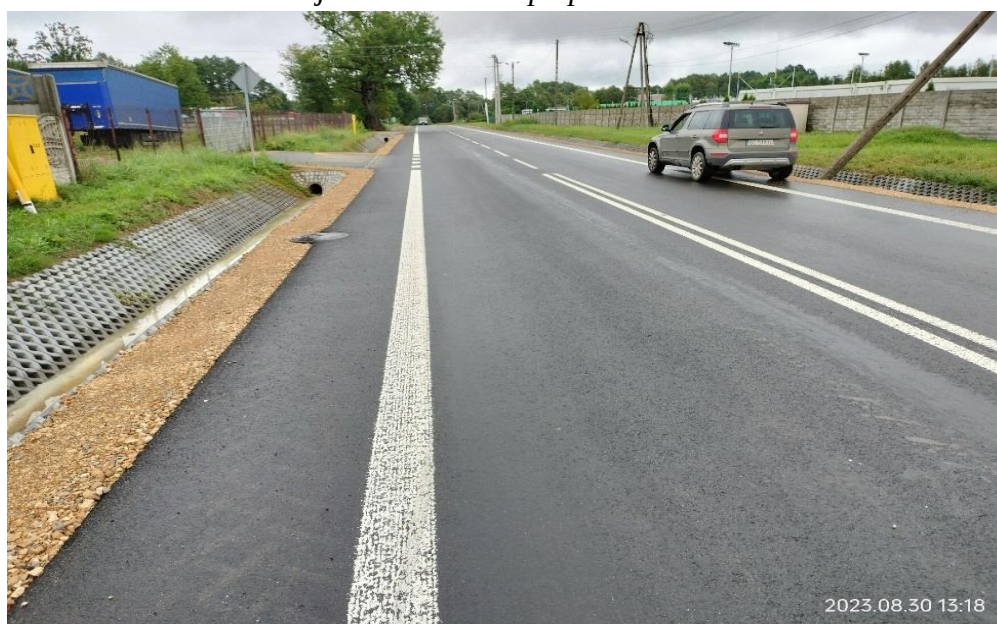
Zdj.40. DP 1023 S po przebudowie
