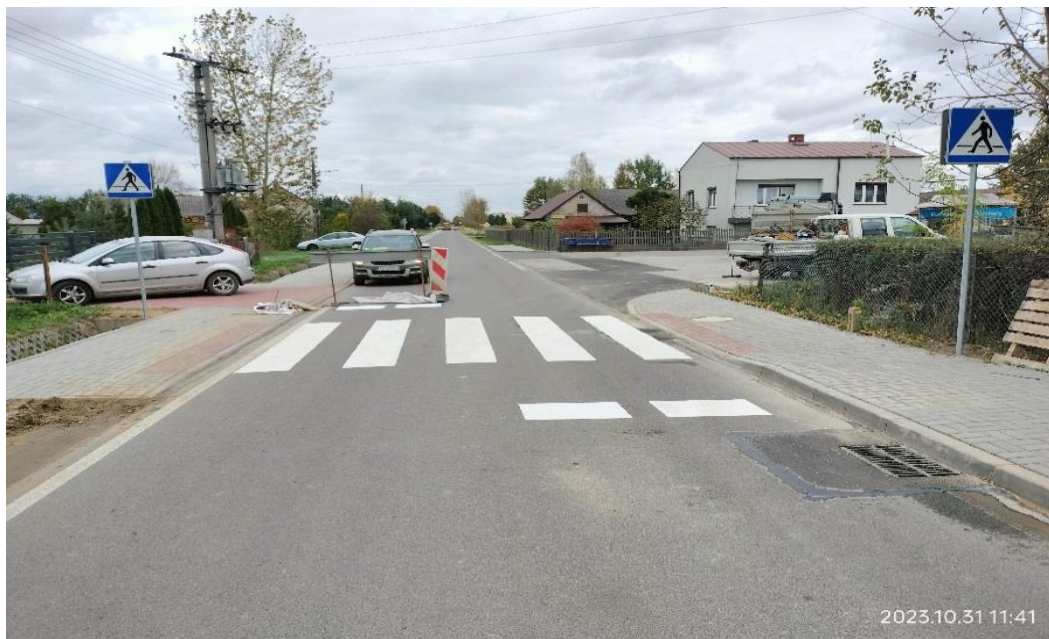
Zdj.35.DP 1077 po przebudowie
