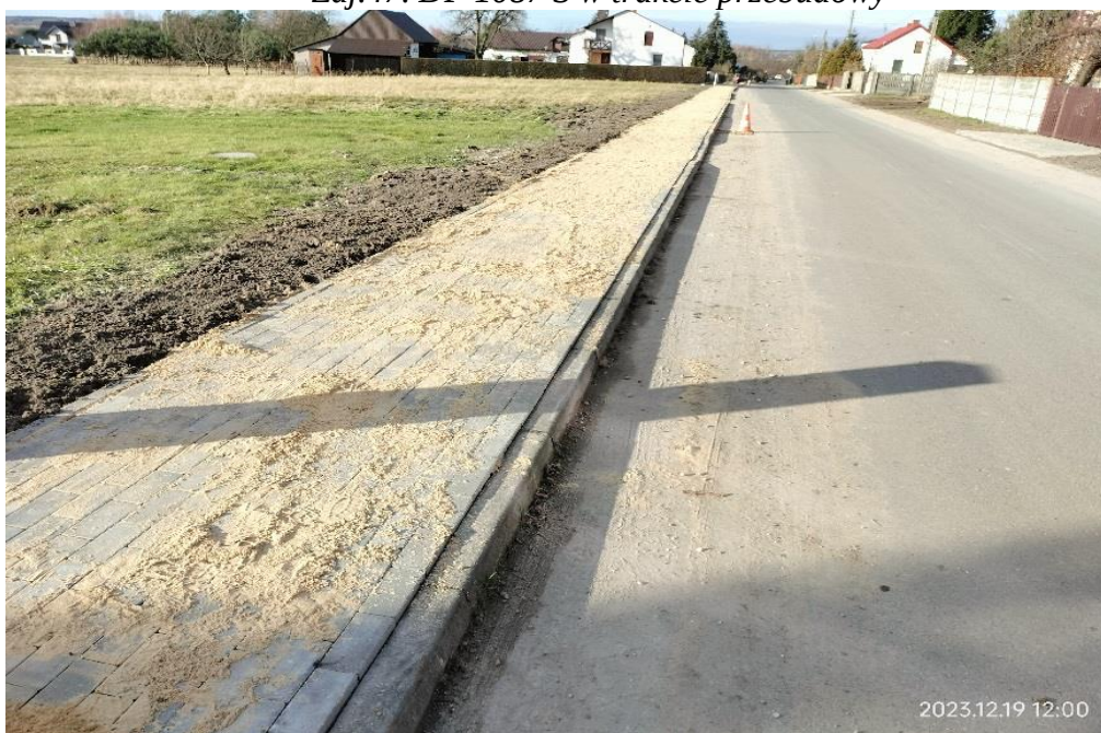
Zdj.48. DP 1087 S po przebudowie
