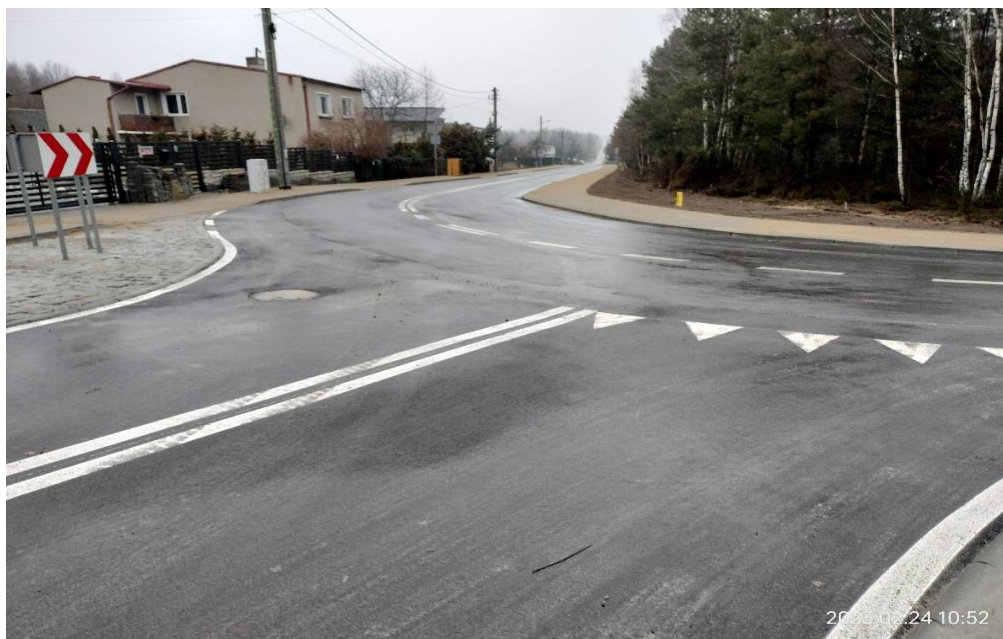
Zdj.37. DP 1051 po przebudowie
