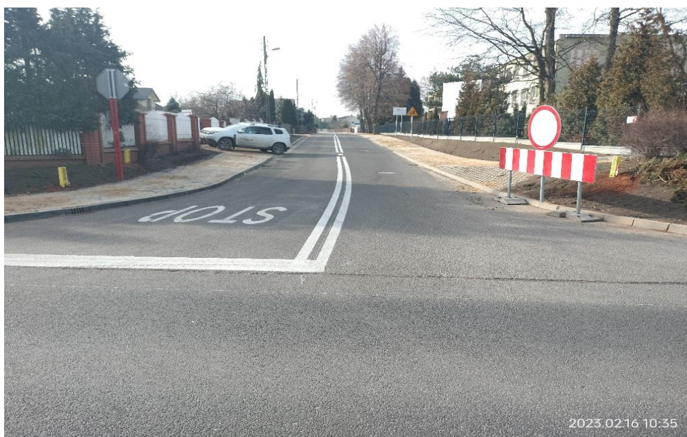
Zdj38. DP 1051 po przebudowie
